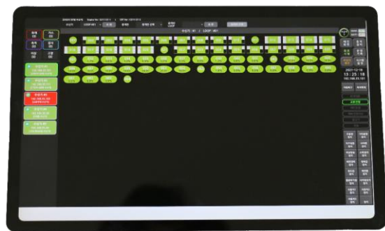
개별 수신기의 소방 설비 상태 감시
